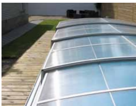
Taktäckning med 10 mm kanalplast med väl isolerande egenskaper.
